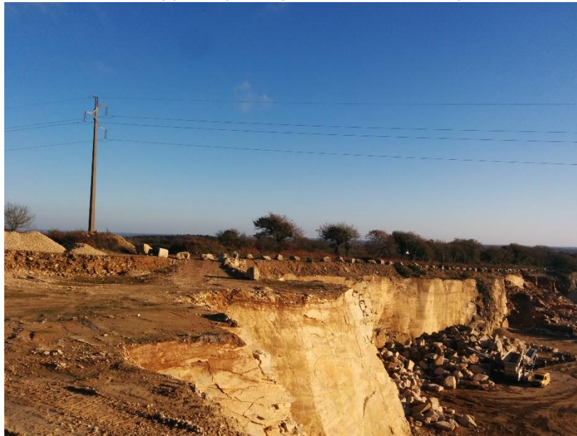
Poteau électrique et haie sur talus à déplacer – Photo CE
