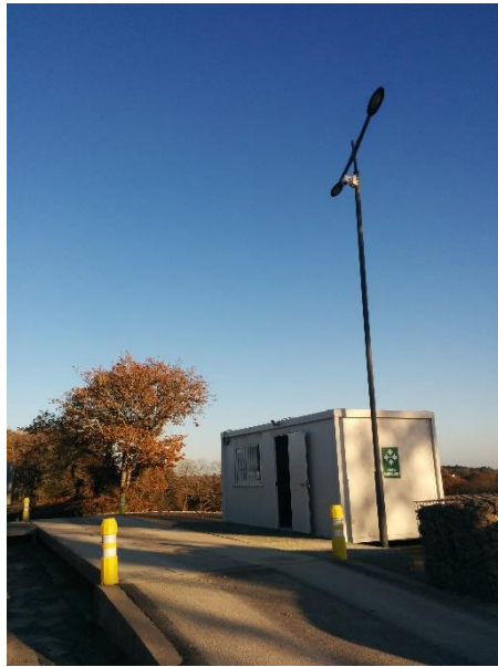
Pont bascule et mât avec appareil photo pour contrôle des dépôts en ISDI – Photo CE
